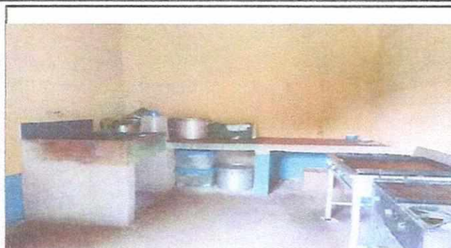
REPARACION DE COCINA
