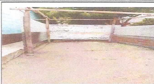
REPARACION DE BODEGA
