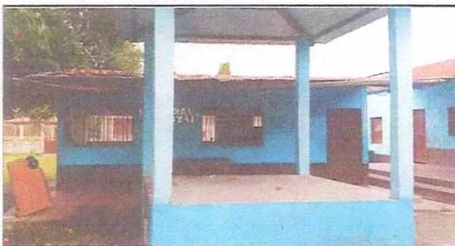
REPARACION DE TECHO
