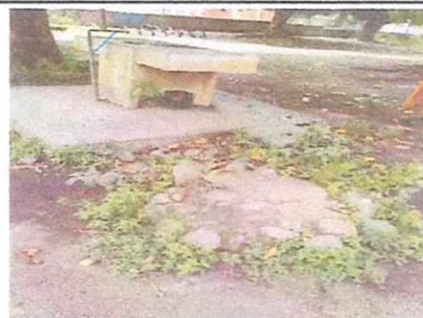
REPARACION DE PILA Y TORTA CEMENTO
