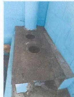
Foto 6: COCINA: Cambio de plancha e instalación de chimenea.
