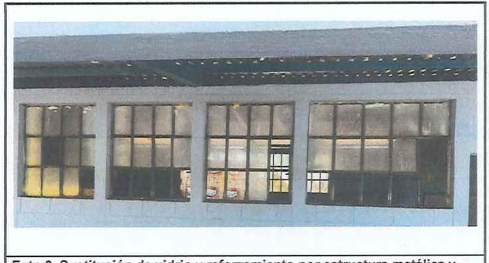
Foto 6: Sustitución de vidrio y reforzamiento por estructura metálica y pintura de las ventanas.
