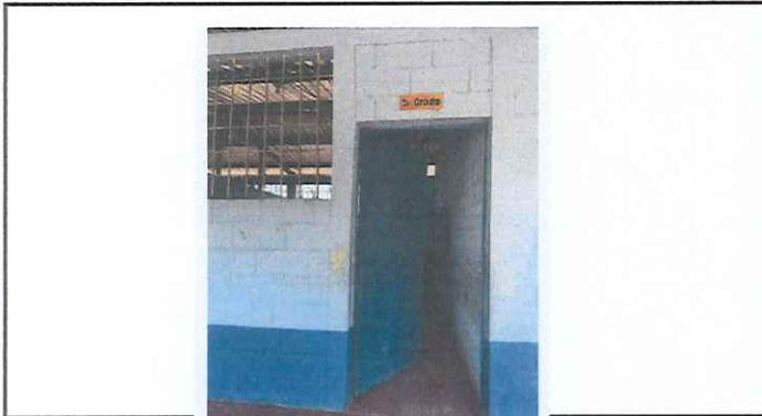
Foto 3: Instalación correcta de puerta + chapa.
