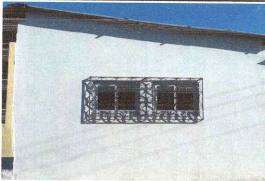
Foto No. 9: Se repellaron paredes exteriores de la escuela.
