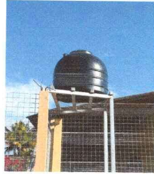
Foto No. 8: Instalación de depósito de agua de 1000 litros
