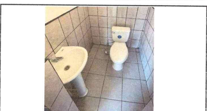
Foto No. 4: Se sustituyó los lavamanos en su totalidad.
