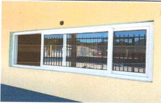
Foto No. 7: se sustituyó en su totalidad 5 ventanas.
