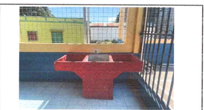
Foto No. 6: Sustitución total de pila.
