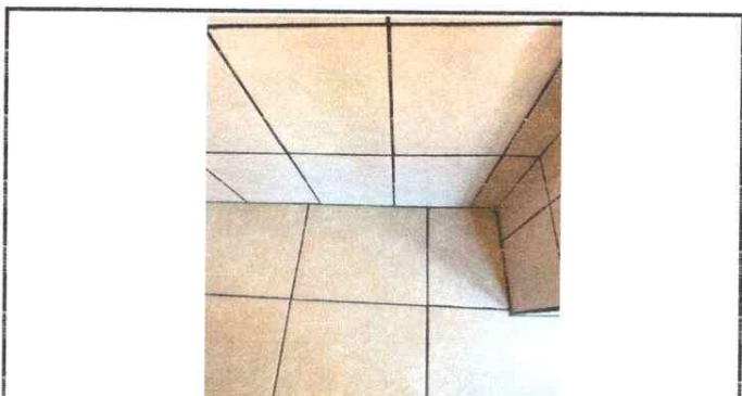
Foto No. 3: Se sustituyó en su totalidad el piso de los servicios sanitarios.
