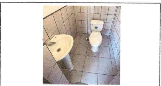
Foto No. 5: Se sustituyó en su totalidad los servicios sanitarios.
