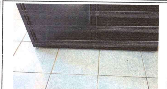
Foto No. 1: Se dio mantenimiento a la estructura de las puertas.
