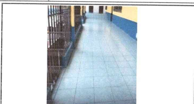
Foto No. 2: Se sustituyó 210 metros cuadrados de piso.
