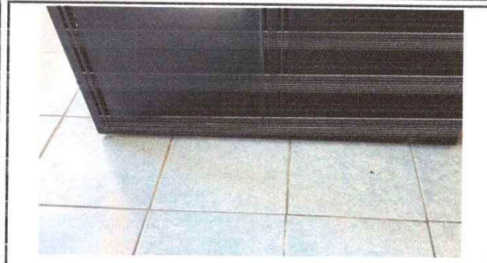
Foto 1. Reparación de puertas de salones de clase.
