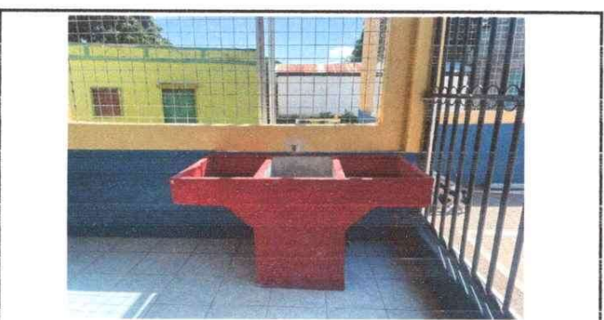
Foto 6. Sustitución de pila.
