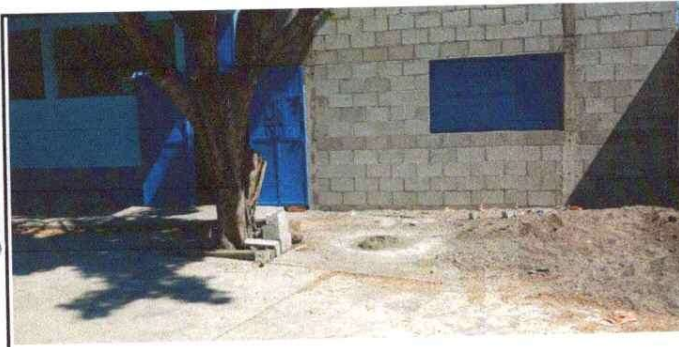
Foto 5: REPARACION DE COCINA
