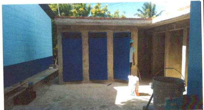
Foto 4: REPARACION Y PINTADO DE PUERTAS Y PORTON
