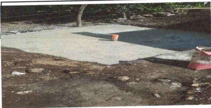
Foto 3: REPARACION DE FOSA SEPTICA
