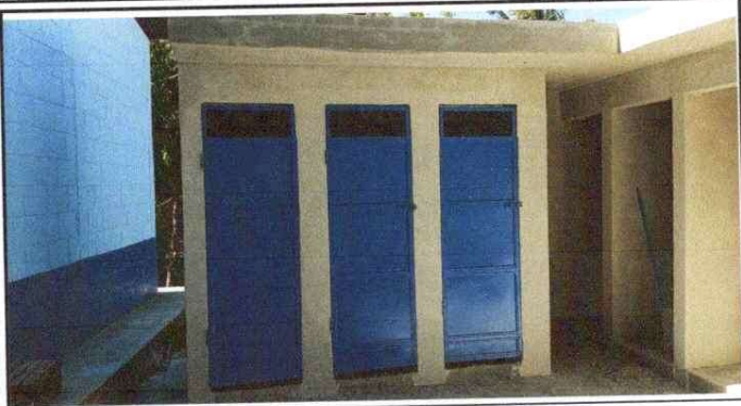
Foto1: REPARACION DEBAÑOS Y AREA DE PILA
