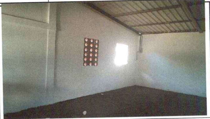
Foto 2: REPARACION DE AULA
