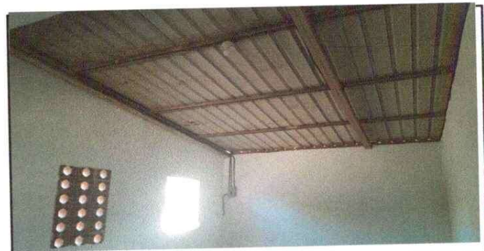
Foto 6: REPARACION DEL SISTEMA ELECTRICO
