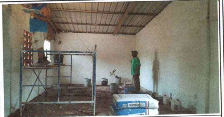
Foto 2: REPARACION DE AULA
