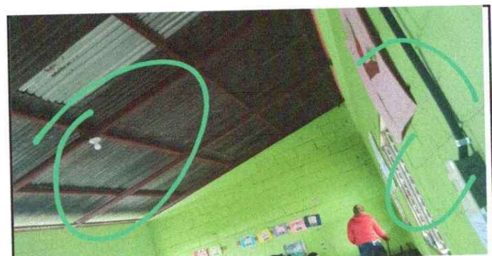
Foto 6: REPARACION DEL SISTEMA ELECTRICO
