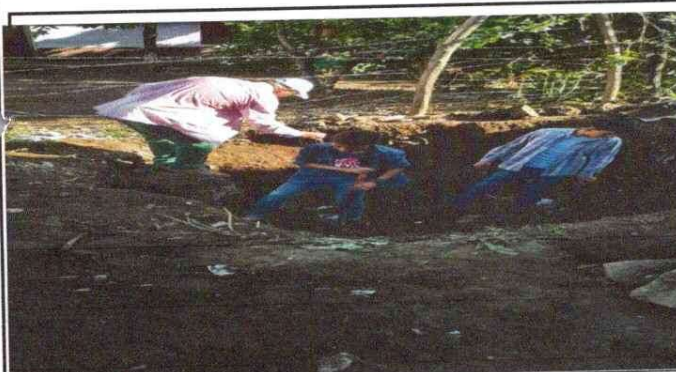
Foto 3: REPARACION DE FOSA SEPTICA
