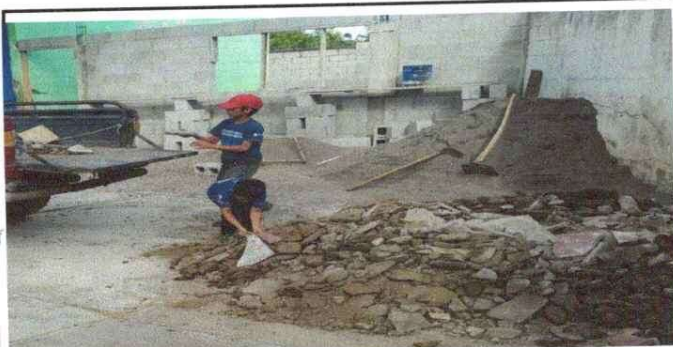
Foto 5: REPARACION DE COCINA
