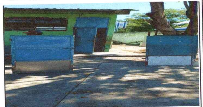
Foto 4: REPARACION Y PINTADO DE PUERTAS Y PORTON
