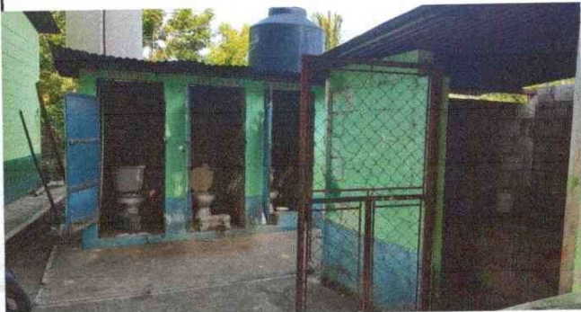
Foto 1: REPARACION DEBAÑOS Y AREA DE PILA
