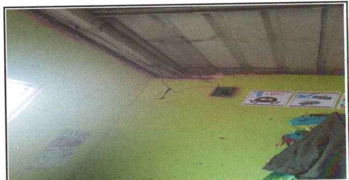
Foto 6: REPARACION DEL SISTEMA ELECTRICO
