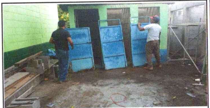
Foto 4: REPARACION Y PINTADO DE PUERTAS Y PORTON
