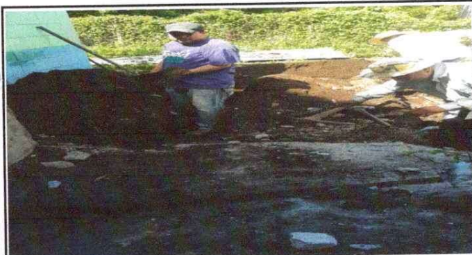
Foto 3: REPARACION DE FOSA SEPTICA
