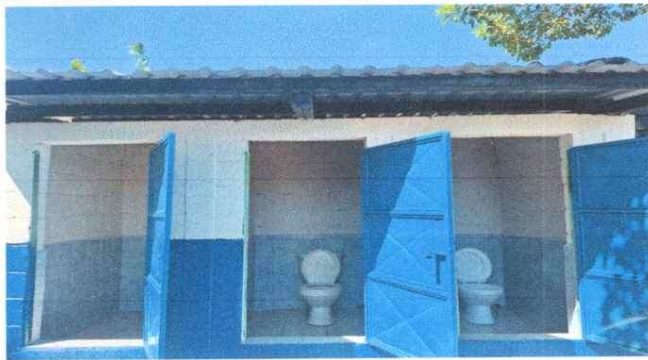
Foto 7. Remodelación de baños. Colocación de azulejos
