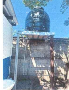
Foto 8. Instalación de Tinaco de agua de 1,100 lt
