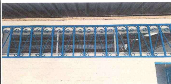
Foto 1. Balcones de las aulas cambiados
