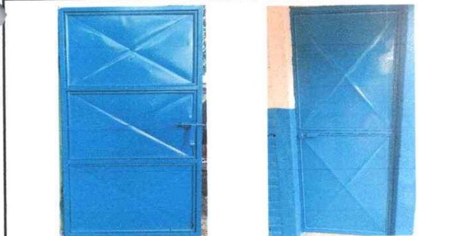
Foto 5. Remozamiento de puertas. Cambio de chapas y pintura
