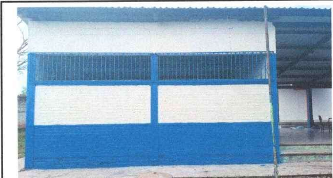
Foto 4. Pintura del centro educativo (incluyendo cocina y baños)
