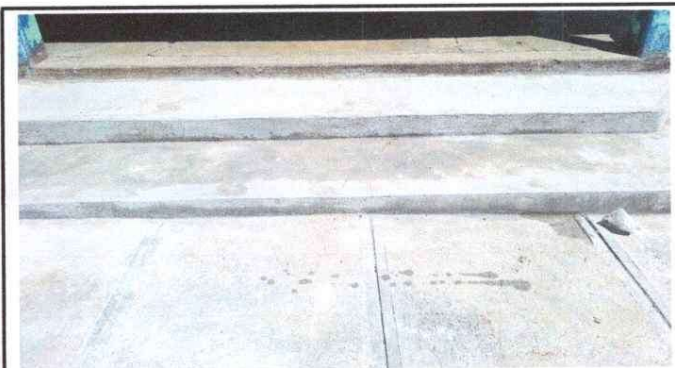
Foto 3. Gradas para subir alcorredor del centro educativo. Reconstruidas
