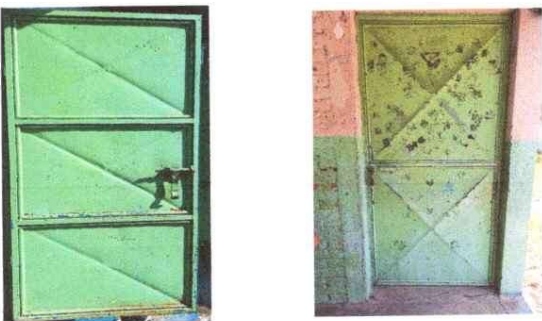
Foto 5. Remozamiento de puertas. Cambio de chapas y pintura
