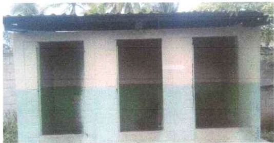
Foto 7. Remodelación de baños. Colocación de azulejos
