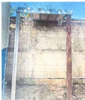
Foto 8. Instalación de Tinaco de agua de 1,100 lt
