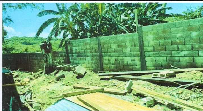
Foto 1: REPARACION DE MURO PERIMETRAL
