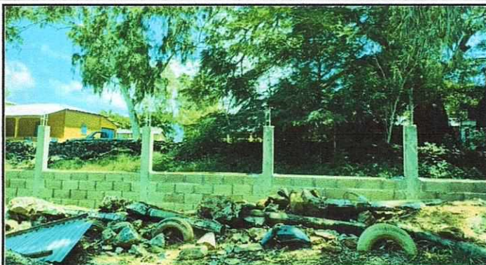
Foto 2: REPARACION MURO PERIMETRAL
