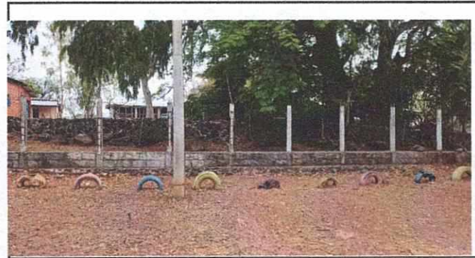
REPARACION DE MURO PERIMETRAL
