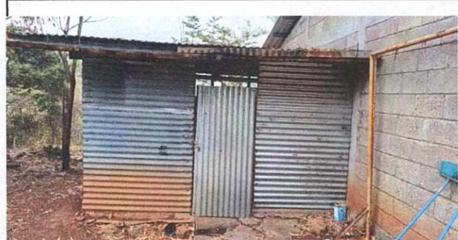
REPARACION DE COCINA
