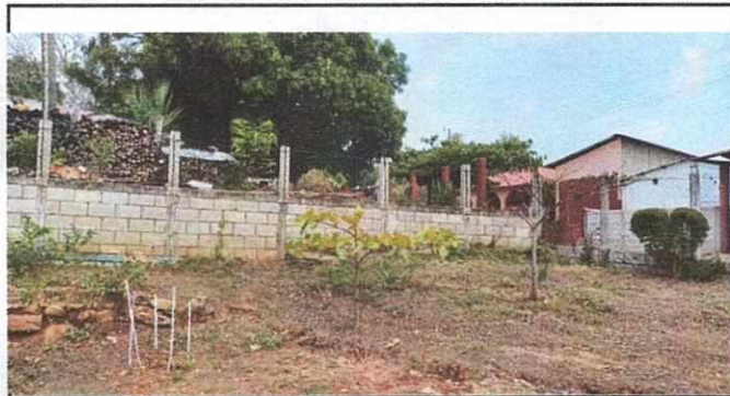
REPARACION DE MURO PERIMETRAL
