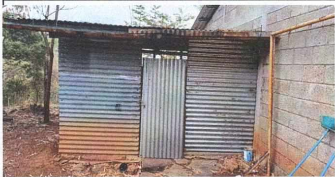
REPARACION DE COCINA
