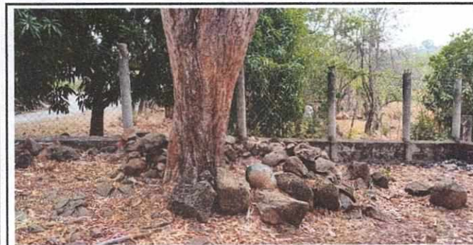
Foto 5: REPARACION DE MURO PERIMETRAL
