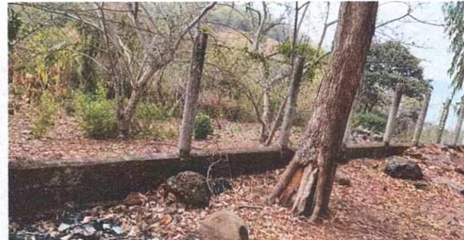
Foto 6: REPARACION DE MURO PERIMETRAL
