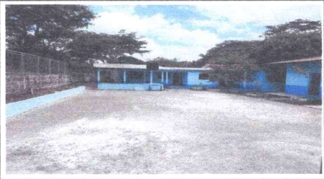
Foto 2: Muro de contención
