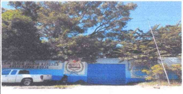
Reparación de portón
