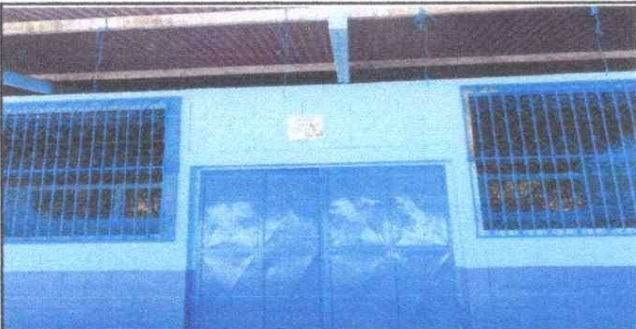
Puertas y balcones reparados y pintados
