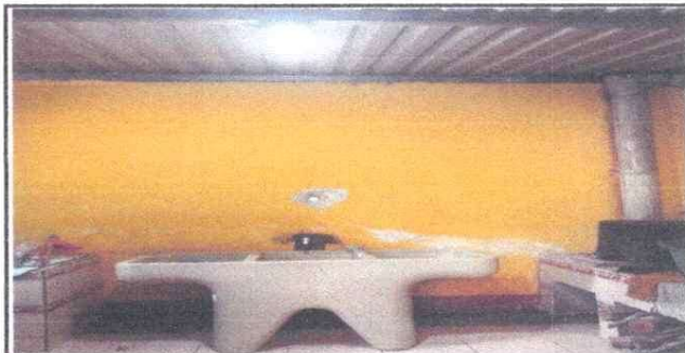
Foto 6: Remodelacion de cocina
