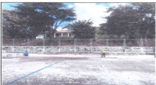
Foto 7: Elaboración de muro de contención.
