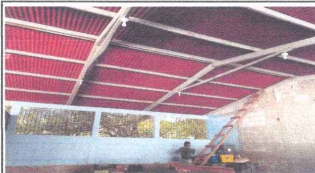
Foto 2: Pintura general de aulas, cocina, servicios sanitarios (dentro y fuera )
