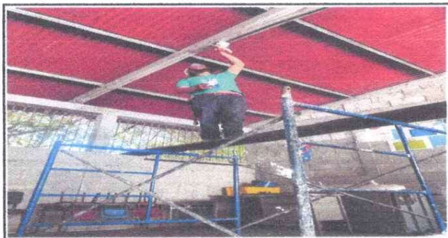
Foto 5: Reparación de sistema eléctrico.
