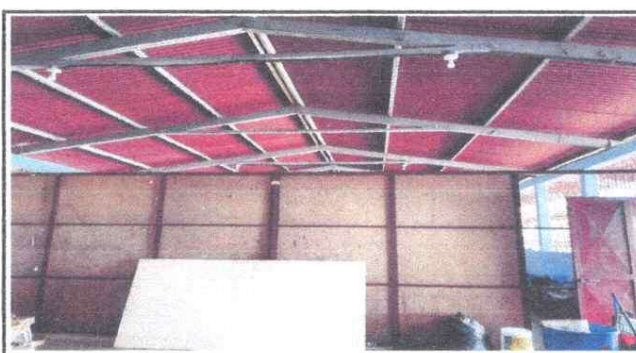
Foto 8: Reparación de división de salón de usos múltiples (cancel).
