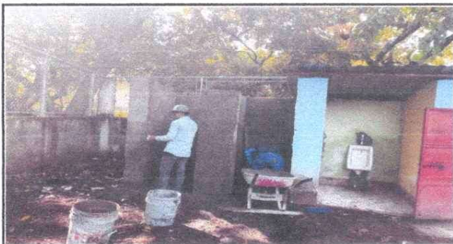
Foto 3: Remodelacion del área de servicios sanitarios
