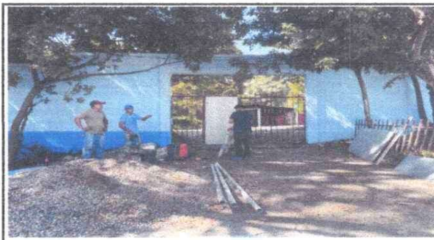
Foto 4: Reparación de portón de entrada.
