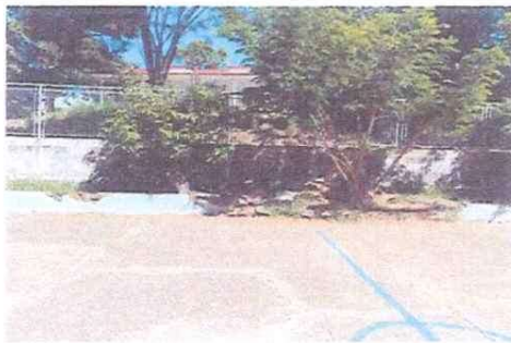
Foto 9: Elaboración de muro de contención
