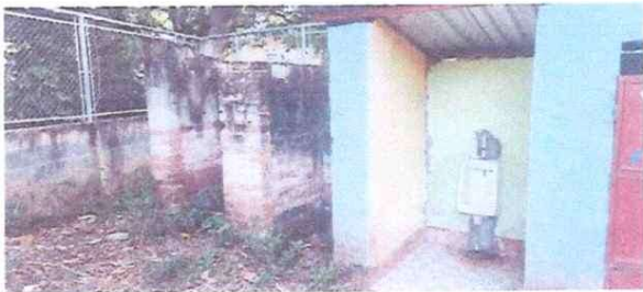
Foto 5: Remodelación del área de sanitarios
