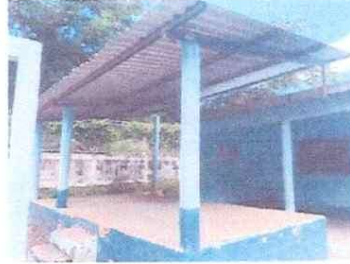
Foto 2: Colocación de Piso Cerámico
