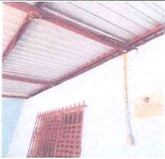
Foto 7: Reparación del sistema eléctrico
