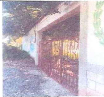
Foto 6: Reparación de portón de entrada
