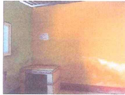
Foto 8: Remodelación de cocina
