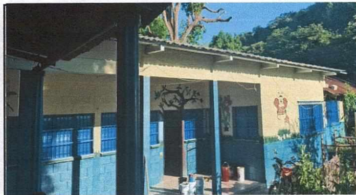
Foto 3: Reparación de techo(Sustitución de duralita por estructura y lámina)
