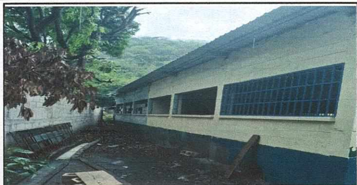
Foto1: Reparación y elaboración de ventanas y balcones
