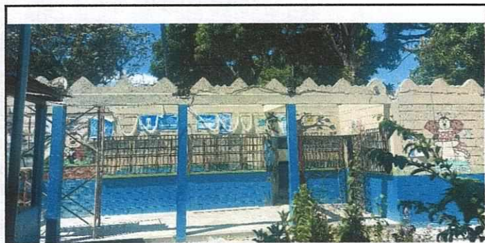
Foto 3: Reparación de techo(Sustitución de duralita por estructura y lámina)
