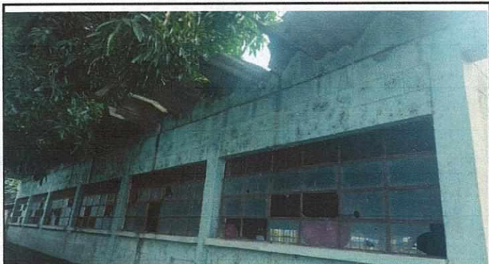
Foto1: Reparación y elaboración de ventanas y balcones
