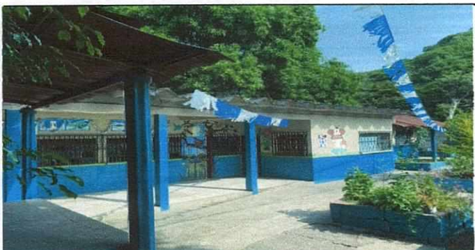
Foto 3: Reparación de techo (sustitución de duralita por estructura y lámina)
