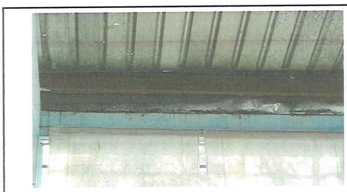
Foto 3: Canales y bajadas de agua pluvial.
