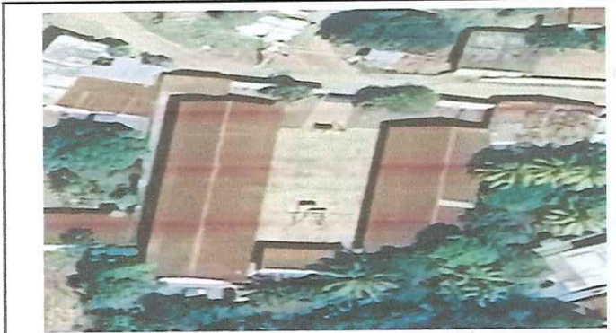
Foto1: Cubierta de lamina.
