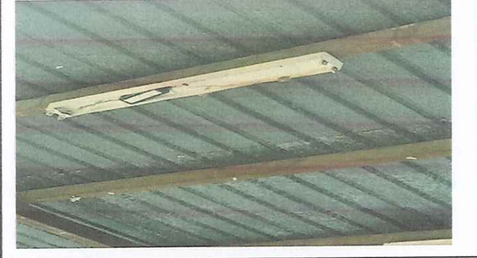
Foto 2: Reparacion de sistema electrico.
