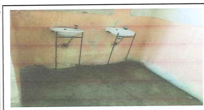
Foto 5: Pintura en muros interior y exterior.
