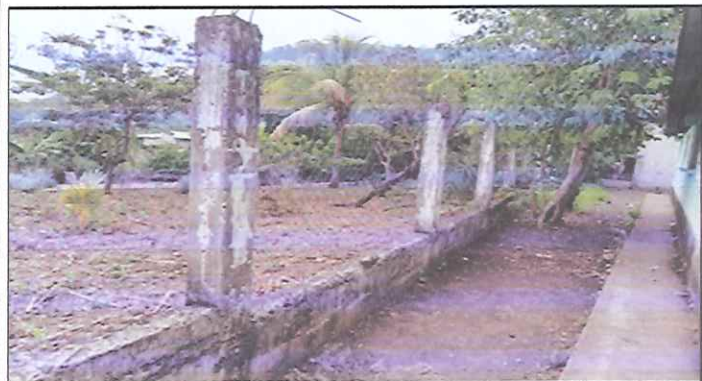
Foto 3: Reparación de muro perimetral.
