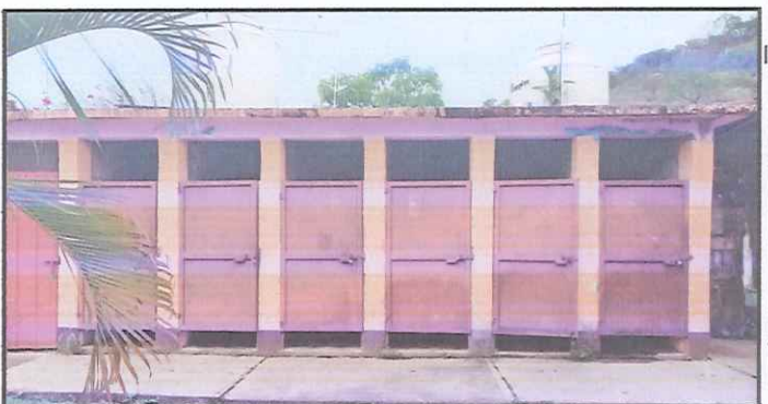
Foto 6: Instalación de ventanas de cedazo
