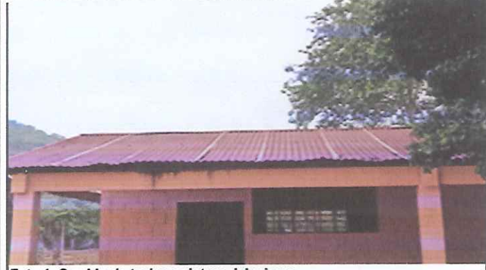
Foto 1: Cambio de techo y pintura del mismo.
