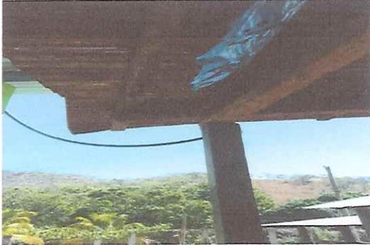
Foto 1: Cubierta de lamina se sustituirá el techo de lámina debido a que estas se encuentran ya en terminos desperfectos y con agujeros
