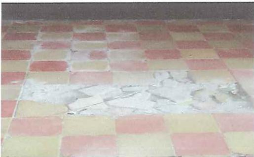
Foto 5: Sustitución de piso y torta de cemento de aulas, cocina y baños
