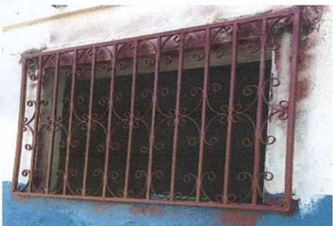
Foto 3 reparacion de ventanas
