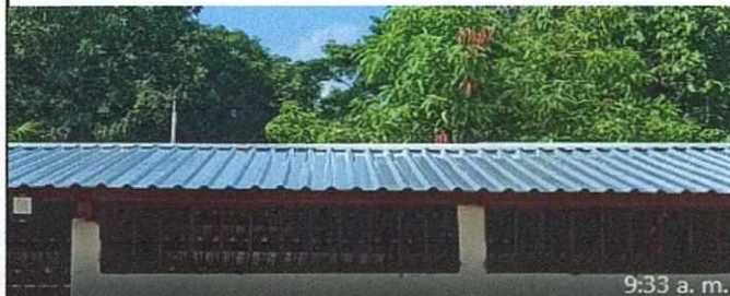
Foto 2 reparacion de techo en las aulas
