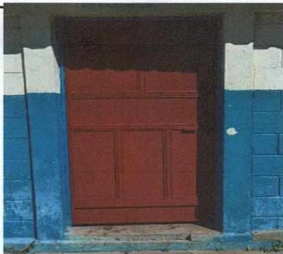
Foto 5: reparacion de puerta y chapa
