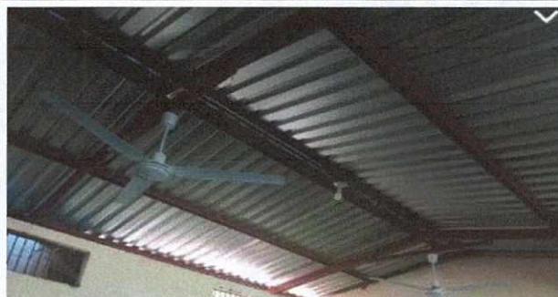
Foto 6: Reparacion de Sistema electrico
