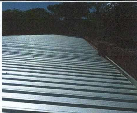
Foto 1. Techo. Cambio de techo en las aulas
