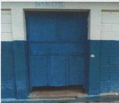
Foto 5: Reparacion de puerta y chapa
