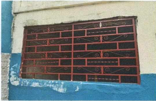
foto 3 reparacion de ventanas
