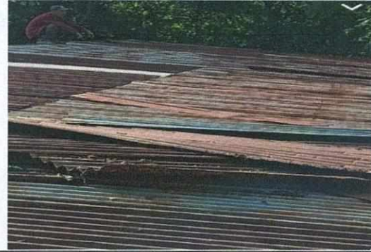
foto 2 cambio de techo en aulas
