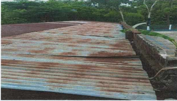
foto 1. Techo. Cambio de techo en las aulas
