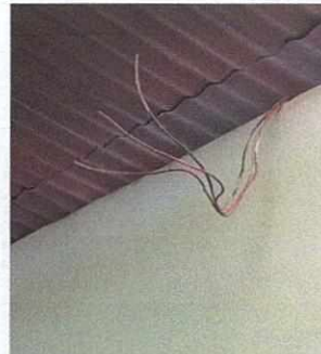
Foto Reparacion de Sistema Electrico
