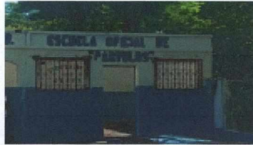
Foto 4 rearacion de ventanas
