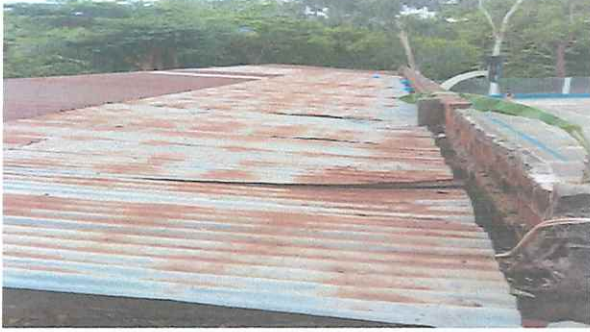
foto 1. Techo. Cambio de techo en las aulas
