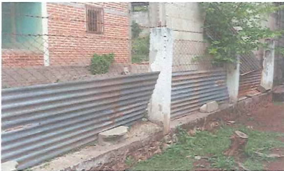
Foto 5: reparacion de muro perimetral
