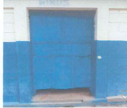
foto 2 reparacion de puertas y chapas
