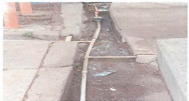
Foto 6: reparacion de red de agua
