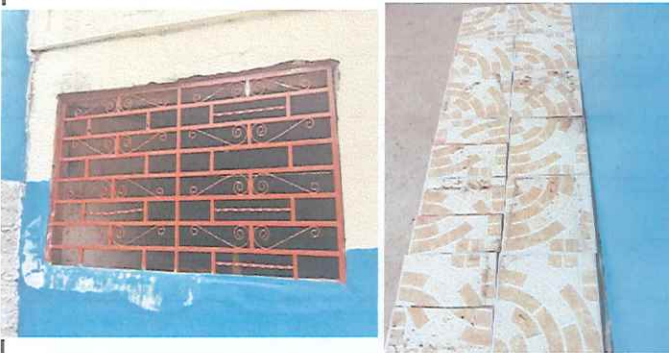
foto 3 reparacion de ventanas y reparacion de piso
