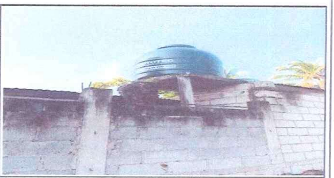
Foto 6: TINACO; Reubicación de tinaco y construcción de base.
