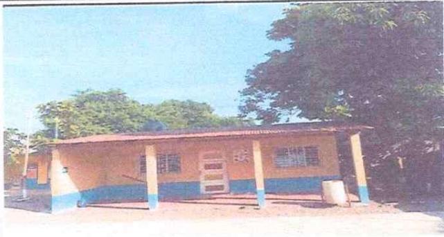
Foto7: Cambio de Lámina: Se cambiará la lámina anacalada a Troquelada en áulas.
