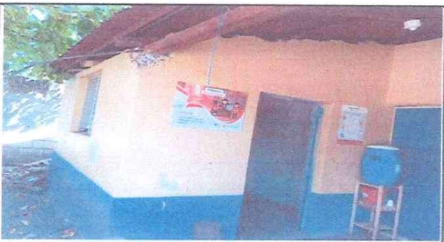
Foto 3: ACABADO: Aplicación de Acabado en LEVANTADO de Block en interior y exterior de techo.
