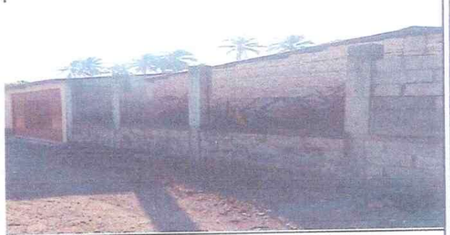
Foto 8: MURO: Levantado de Mampostería para cerramiento.
