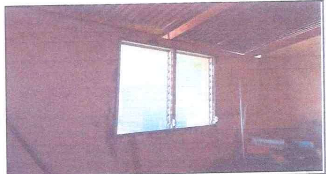
Foto 10: Ventana: instalación de balcón con cedazo
