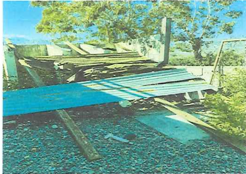
Foto 1: Cubierta de lámina y estructura de techo
