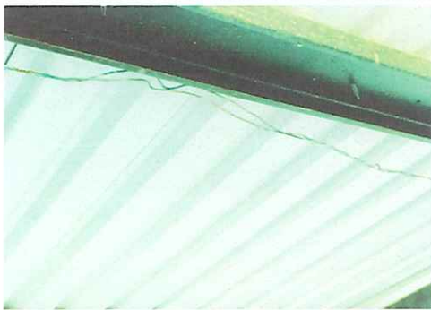
Foto 5: Reparación de sistema eléctrico
