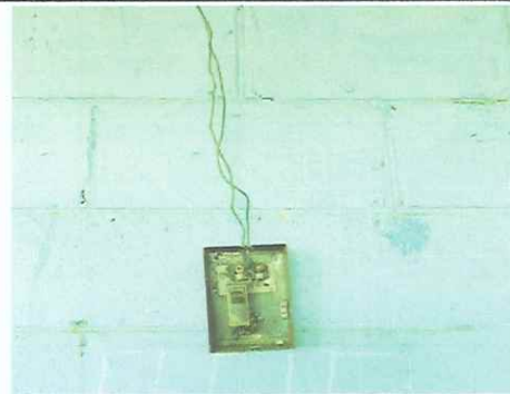
Foto 6: Reparación de sistema eléctrico
