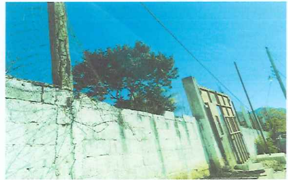
Foto 4: Reparación de muro perimetral
