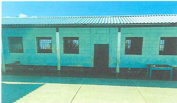
Foto 3: Pintura en muros exteriores e interiores
