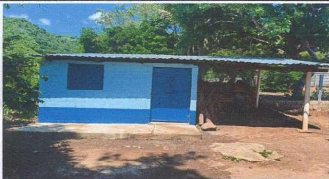
Foto 3: Reparación del techo en mal estado, colocación de puerta y ventana en la Cocina.
