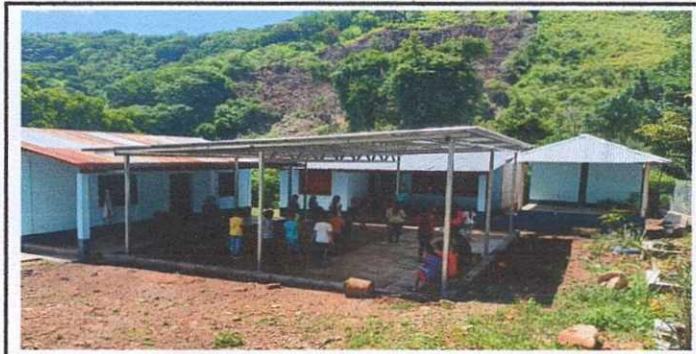
Foto 6: Reparación de Patio y Pavimentado.
