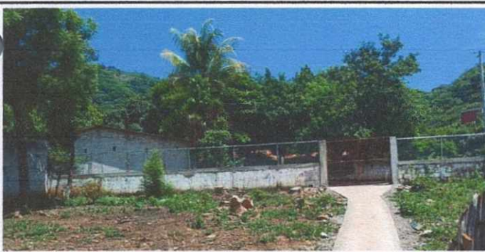
Foto 5: Reparación del Muro Perimetral.
