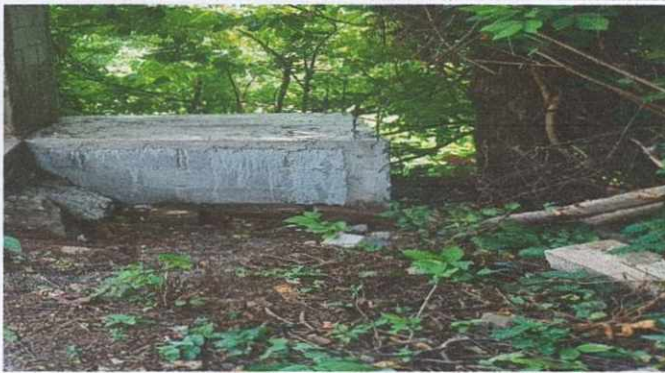
Foto 1: Reparación de Drenaje.
