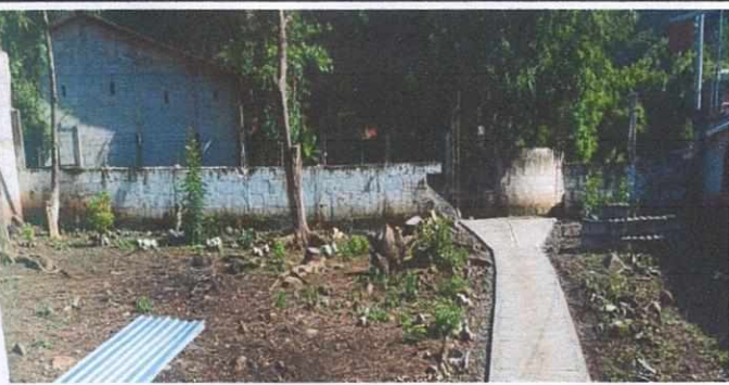
Foto 5: Reparación del Muro Perimetral.
