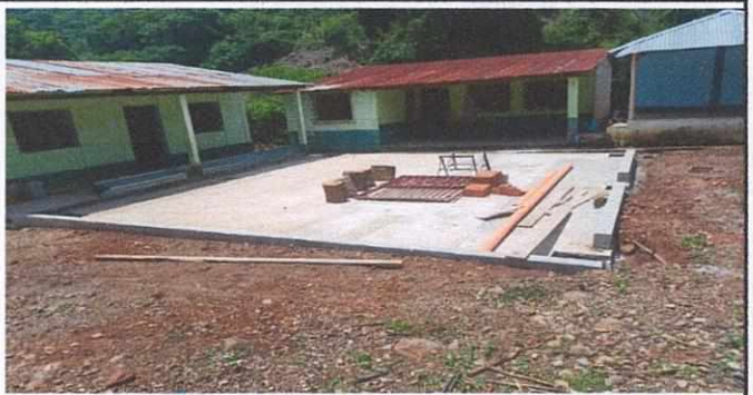
Foto 6: Reparación de Patio y Pavimentado.
