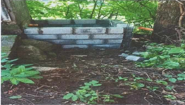
Foto 1: Reparación de Drenaje.
