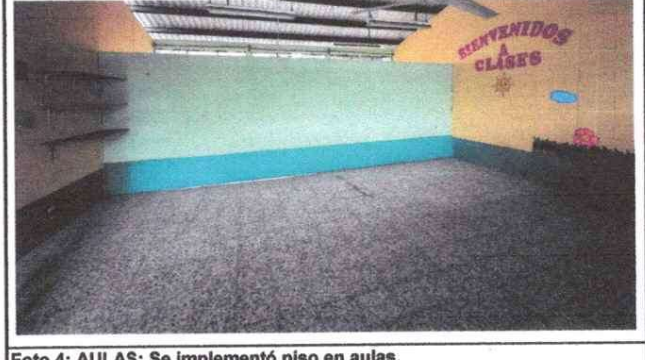
Foto 4: AULAS: Se implementó piso en aulas.
