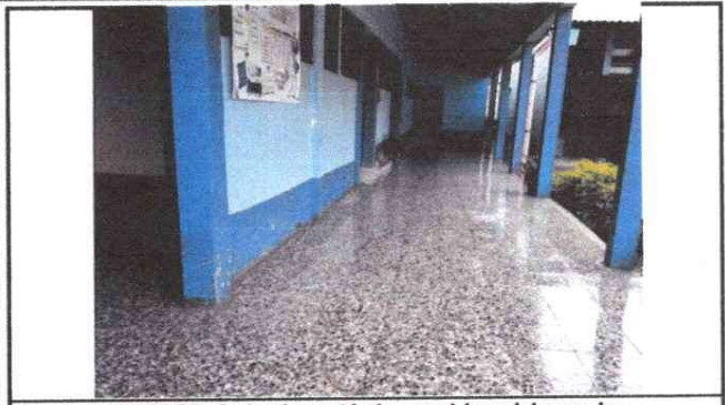
Foto 1: CORREDOR: Se implementó piso en el área del corredor.
