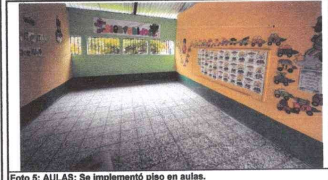
Foto 5: AULAS: Se implementó piso en aulas.
