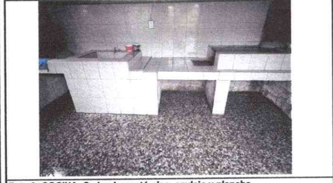
Foto 3: COCINA: Se implementó piso, azulejo y plancha.
