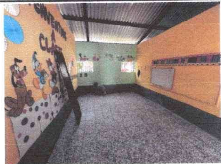
Foto 6: AULAS: Se implementa piso en aulas.
