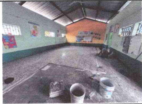
Foto 2: AULAS: Se implementa piso en aulas.
