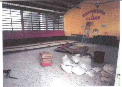
Foto 4: AULAS: Se implementa piso en aulas.
