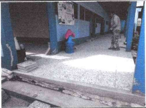
Foto 1: CORREDOR: Se implementa piso en el área del corredor.
