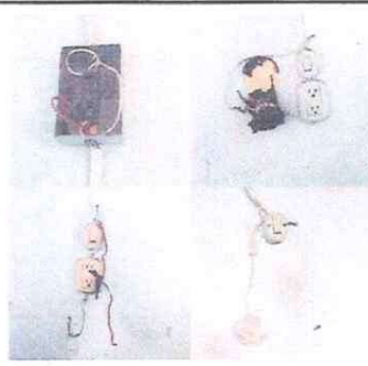
Foto 6: Sistema electrico en mal estado
