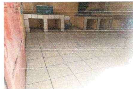
Piso de Cocina Finalizado.
