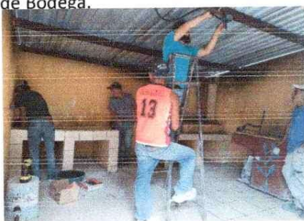
Reparación de Bodega.
