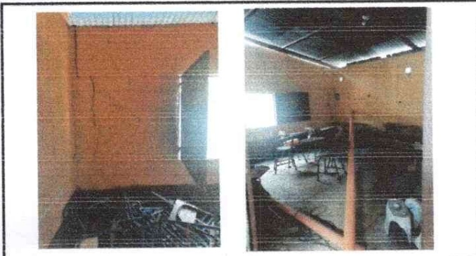
REPARACION DE BODEGA
