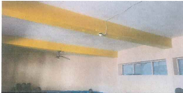
Foto 11: REPARACIÓN DEL SISTEMA ELECTRICO
