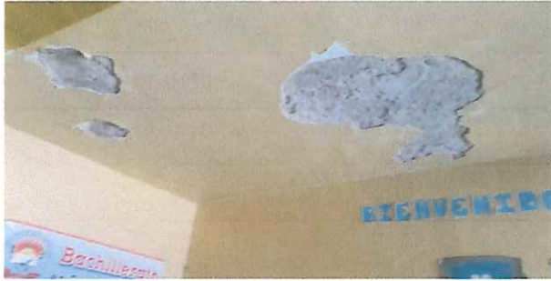
Foto 7: PINTURA MUROS INTERIOR Y EXTERIOR Y PARTE DEL TECHO
