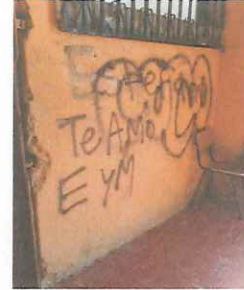
Foto 8: PINTURA MUROS INTERIOR Y EXTERIOR Y PARTE DEL TECHO
