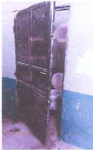
Foto 3 PUERTAS: Reparación de puerta de metal y cambio de chapa
