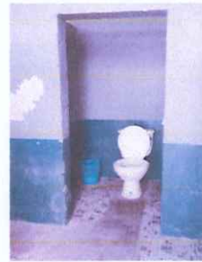
Foto 5: PUERTAS: Instalación de Puerta de metal para baño
