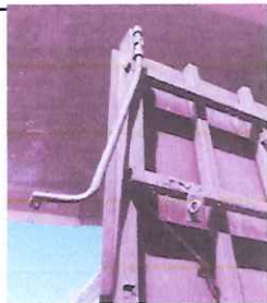
Foto 5: PUERTAS: Reparación de Porton
