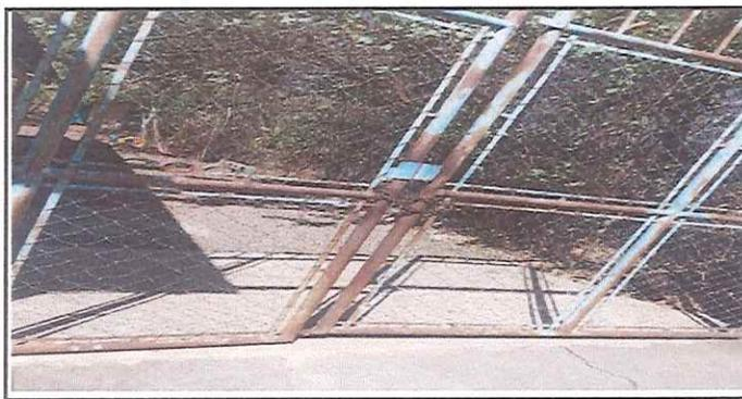
Foto 5: MANTENIMIENTO A PORTONES: Se reparará el portón exterior y se le brindará mantenimiento de estructura metal.
