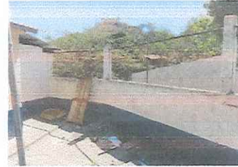
Foto 2: Reparar muro perimetral.
