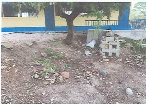
FOTO 5: PATIO DESNIVELADO, SE RELLENARA Y COMPACTARA EL AREA PARA LUEGO FUNDIR UNA TORTA DE CEMENTO DE 7 CM CON MALLA ELECTRO SOLDADA
