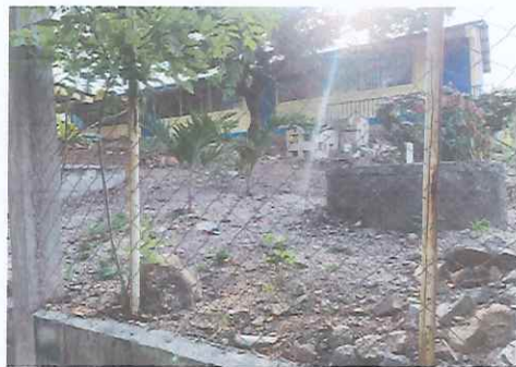
FOTO 6: MURO DE CONTENCIÓN DE MAMPOSTERIA DE PIEDRA A BASE DE CEMENTO CON UNA ALTURA MAXIMA DE 1.50 MTS, LUEGO SE NIVELARA CON MURO DE BLOCK A UNA ALTURA DE UN MT
