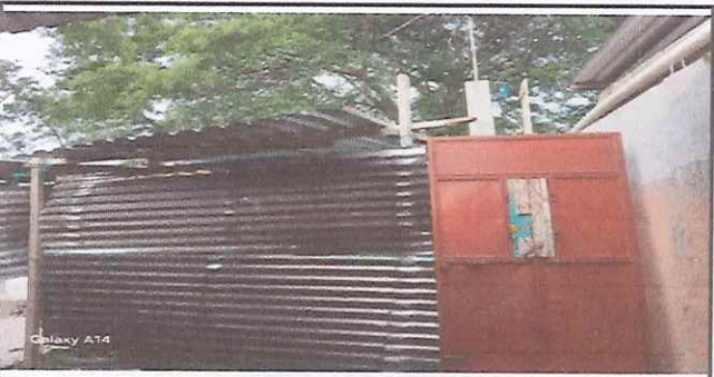
Foto 5: Construcción de bodega
