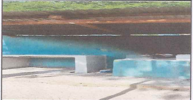
Foto 4: Construcción de cocina
