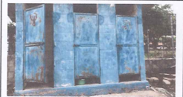
Foto 3: Reparación servicios sanitarios
