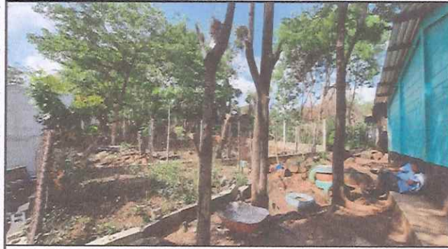
Foto 1: Construcción de muro perimetral
