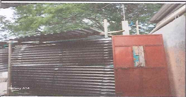
Foto 5: Construcción de bodega
