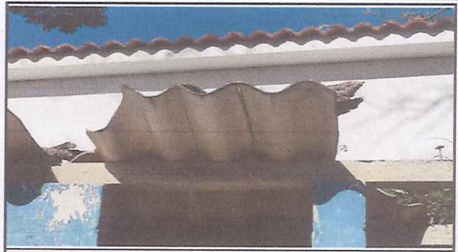
Foto 2: Reparación de techo.
