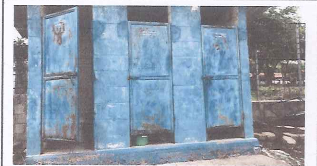
Foto 3: Reparación servicios sanitarios
