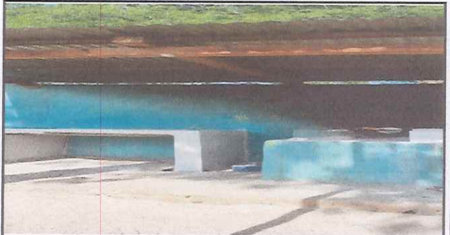
Foto 4: Construcción de cocina
