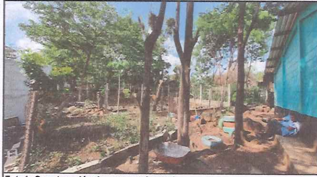
Foto 1: Construcción de muro perimetral
