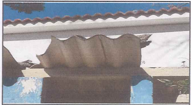
Foto 2: Reparación de techo.
