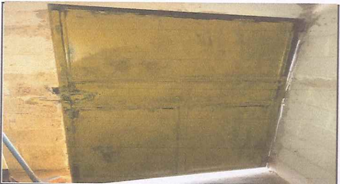
Foto 3: Sustitución de puertas de aulas y cocina.
