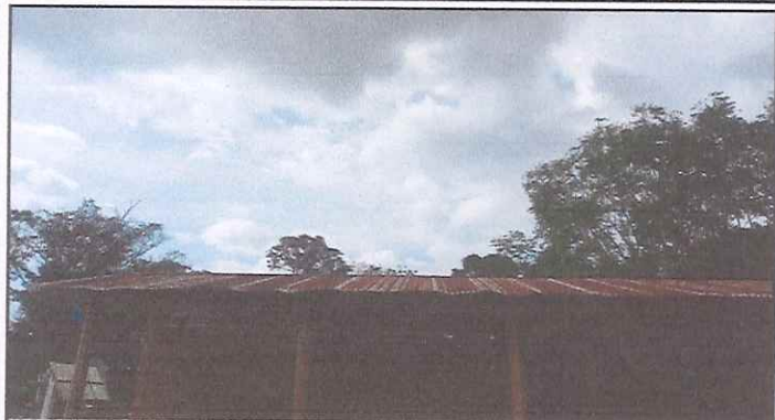
Foto1: Sustitución de lamina de dos aulas y corredor
