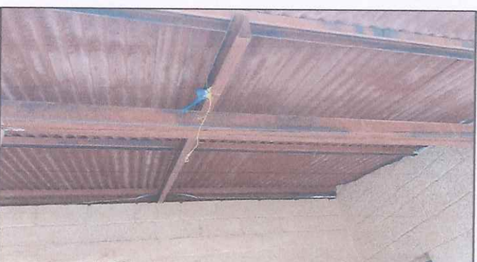
Foto 4: Mantenimiento de estructura de soporte de metal (pintura)
