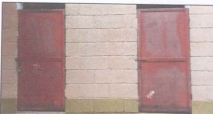
Foto 5: Sustrucción de puertas de baños
