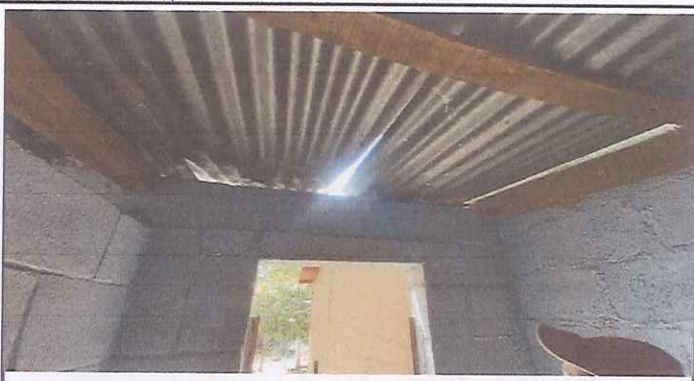
Foto 2: Sustitución de estructura de soporte de madera por metal y sustitución de lamina
