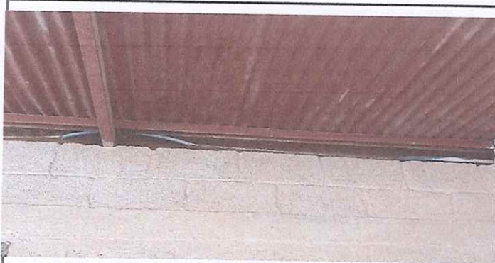
Foto 3: Reparación sistema electrico
