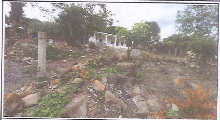
Foto 2: Reparación de muro de contención.
