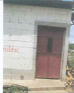
Foto 2: Puerta en mal estado, se sustituirá por puerta metálica para mayor seguridad de la cocina
