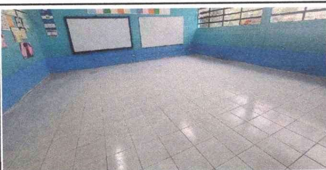
Foto 5: Piso cerámico instalado
