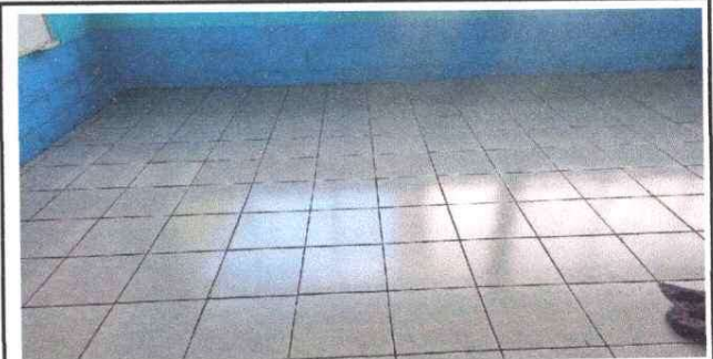
Foto 6: Piso cerámico instalado
