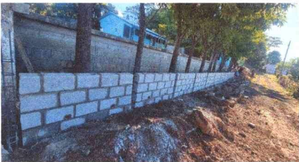
Foto 3: Levantamiento de paredes del muro perimetral
