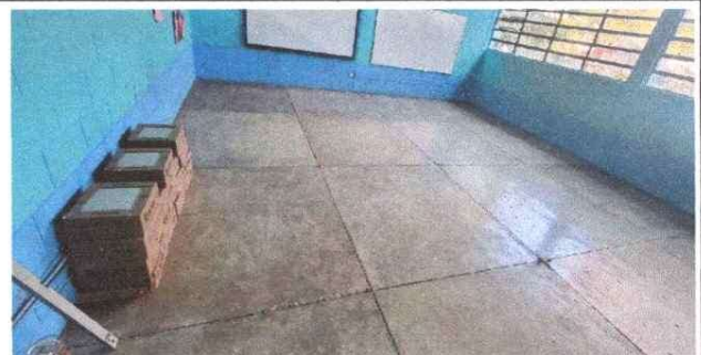
Foto 6: Instalación de piso cerámico
