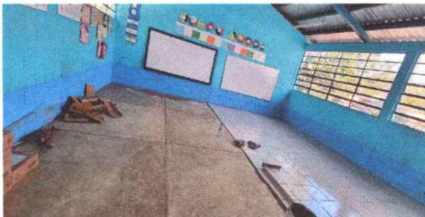
Foto 5: Instalación de piso cerámico
