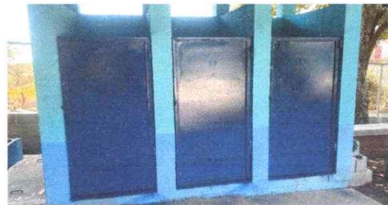
Foto 4: Instalación de puertas
