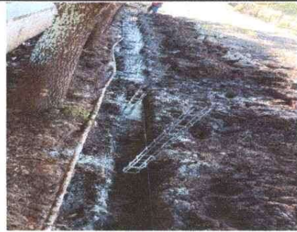
Foto 2: Fundición de arranques y armaduras para columna para el muro perimetral
