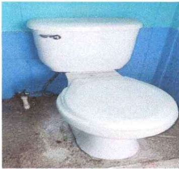
Foto1: Instalación de inodoros
