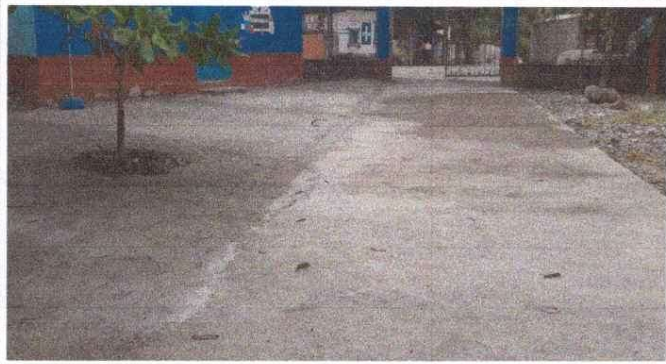
Foto 1: Plancha de concreto de patio terminada
