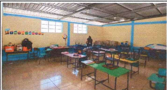
Foto 9: Muros o paredes de interior de aulas Pintadas
