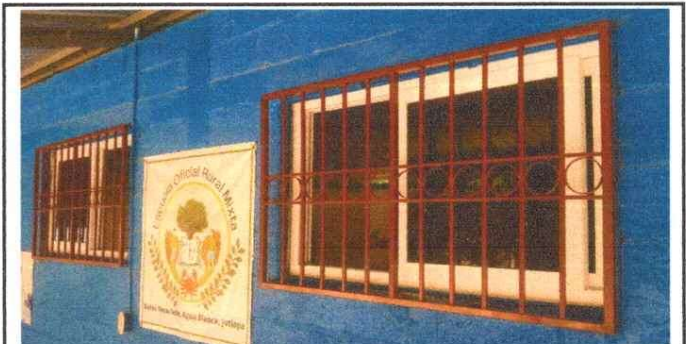
Foto 6: Vidrios, balcones y ventanas nuevas
