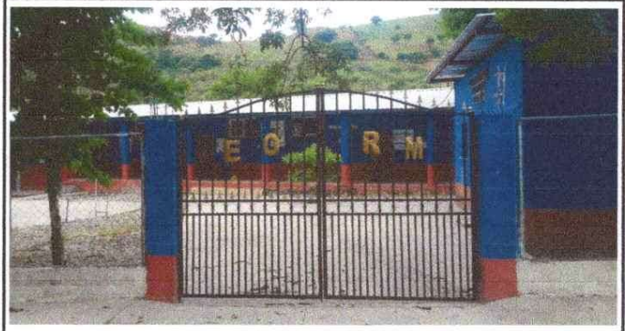
Foto 2: Portón de metal nuevo instalado
