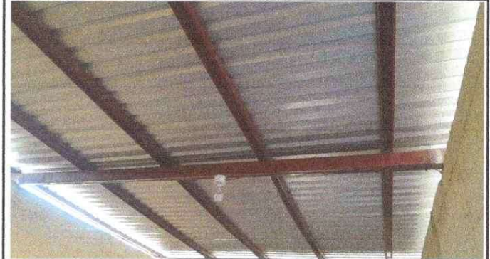
Foto 8: Lámina troquelada, Aluzinc Instalada
