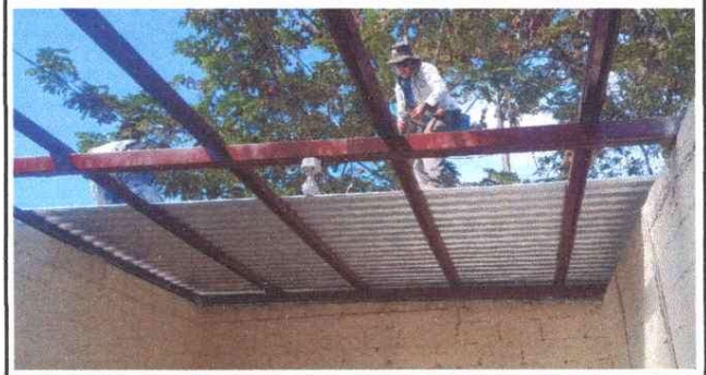
Foto 8: Sustitución de lámina por lámina troquelada, Aluzinc
