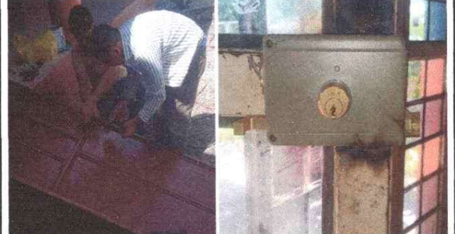
Foto 4: Mantenimiento a estructura de puertas, aplicación de pintura, sujeciones y cambio de chapas
