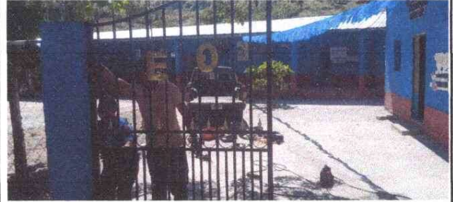
Foto 2: Instalación de portón de metal
