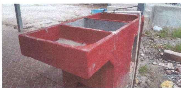
Foto 5: Sustitución de pila de cemento de dos lavaderos
