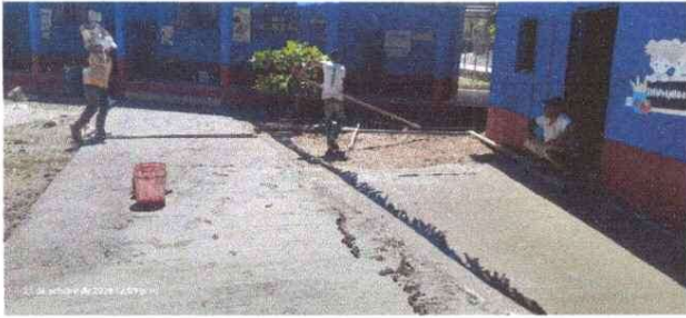
Foto1: Fundición de plancha de concreto de patio
