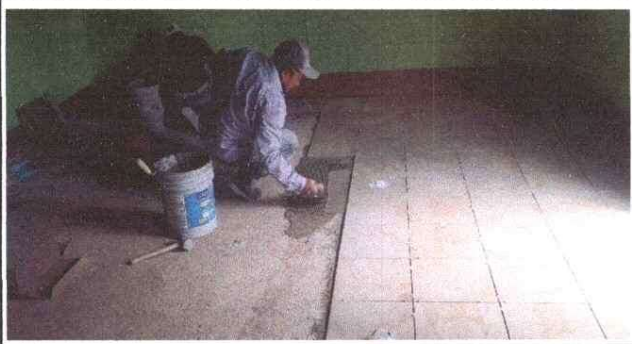
Foto 7: Sustitución e instalación de piso cerámico
