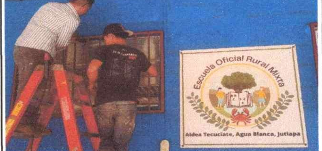
Foto 6: Sustitución de balcones, ventanas y vidrios
