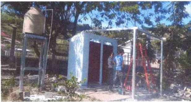
Foto 3: Instalación de soporte de metal y lámina a galera de sanitarios
