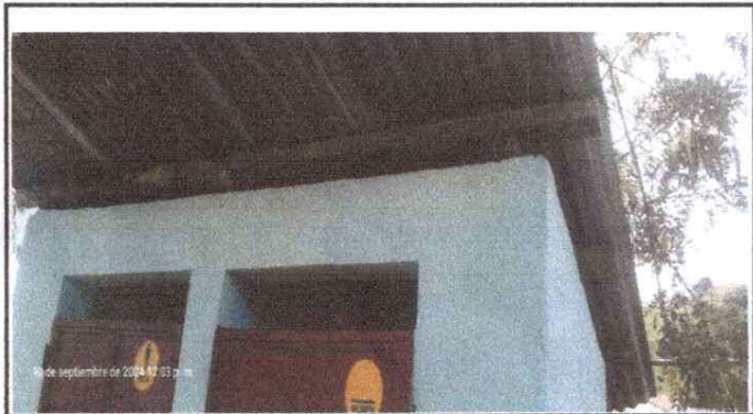
Foto 3: Sustitución de lámina y sustitución de soporte de madera por estructura metálica, galera de sanitarios
