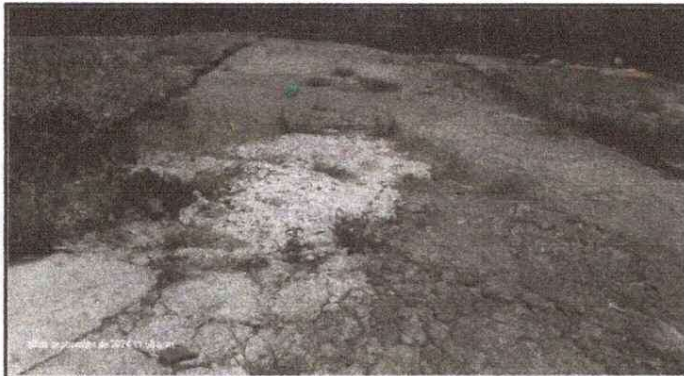
Foto 1: Reparación de plancha de concreto de patio
