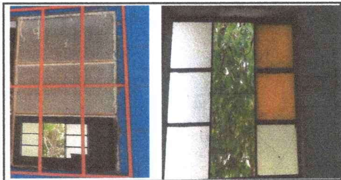
Foto 6: Sustitución de vidrios
