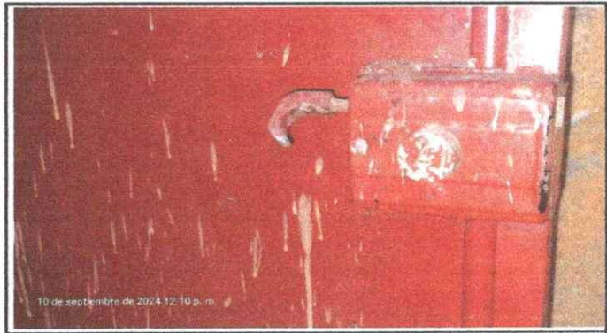
Foto 4: cambio de chapas a puertas
