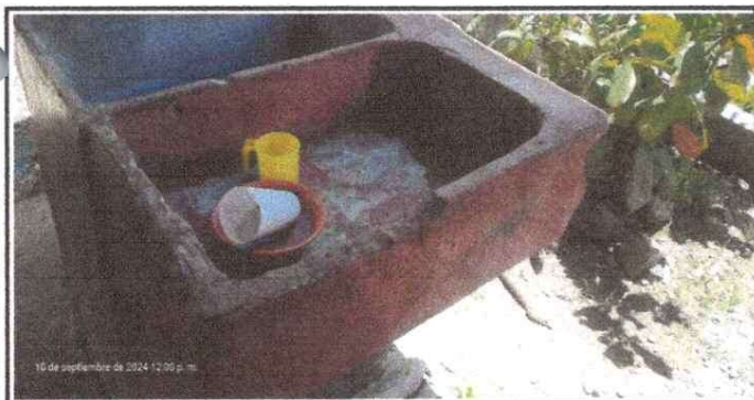
Foto 5: Sustitución de pila de cemento de dos lavaderos
