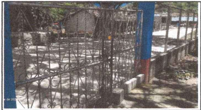
Foto 2: Sustitución de portón de metal
