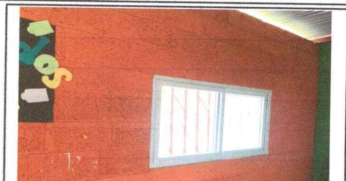
Foto 2: Instalación de ventana de PVC
