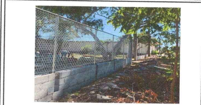
Foto1: Reparación de Muro Perimetral
