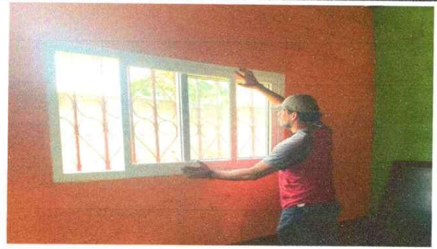
Foto 2: Remodelación de ventana
