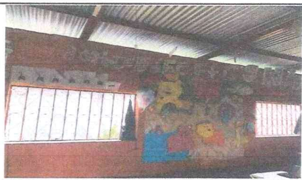
Foto 4: sustitución de ventanas
