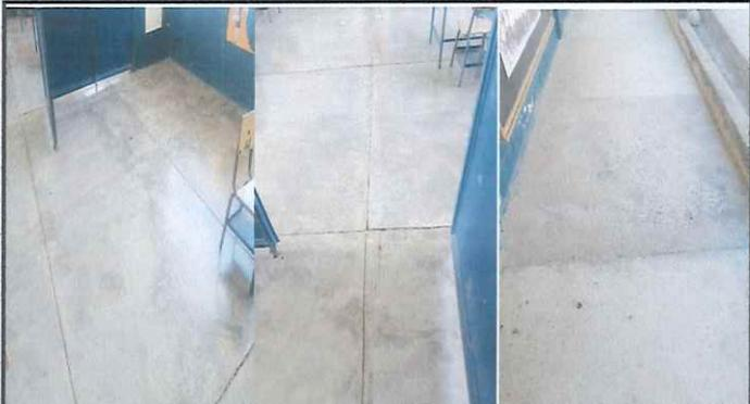
Foto 4: Piso en mal estado, esta todo rajado y hay una parte que es de torta de concreto, se le instalará cerámico a 3 aulas y corredor
