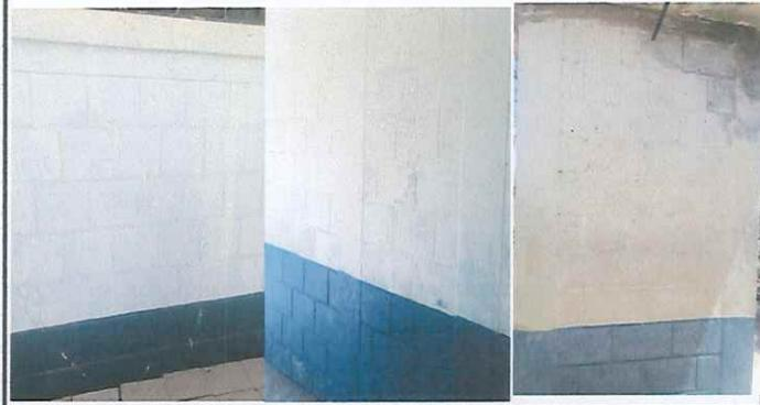
Foto 2: Paredes con la pintura en mal estado, se pintarán las paredes del lado exterior e interior
