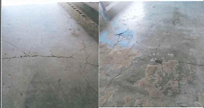
Foto 1: Piso de torta de concreto se encuentra en mal estado, agrietado y se esta levantando, se sustituirá
