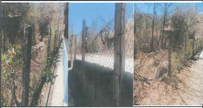
Foto 6: Muro perimetral alrededor de la escuela en mal estado, se reparará el muro de block con tubo hg y malla galvanizada
