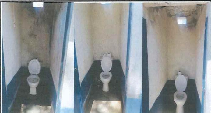
Foto 3: Inodoros en mal estado, se sustituirán los 3 inodoros, se pintaran las paredes y se les instalará cerámico y azulejo
