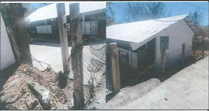
Foto 5: Parte de enfrente de la escuela y del muro perimetral en mal estado, se reparará de block con tubo hg y malla galvanizada y se pintaran las paredes
