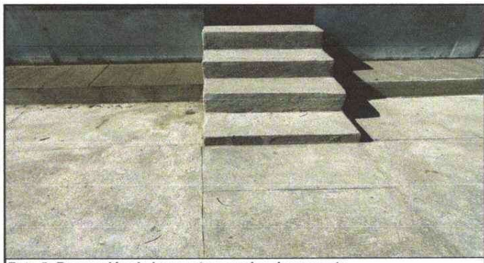
Foto 5: Reparación de banqueta y gradas de concreto.
