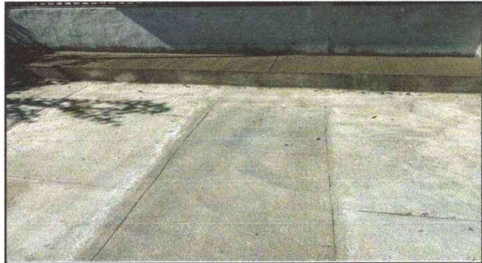
Foto 4: Sustrucción de piso de torta de concreto.
