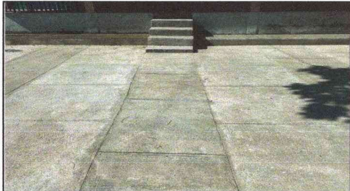
Foto 3: Reparación de banqueta y gradas de concreto
