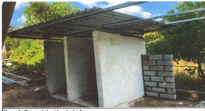
Foto 6: Remodelación de baños.
