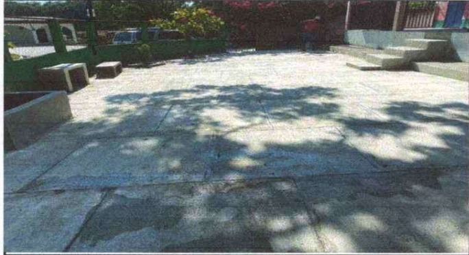
Foto 1: Sustrucción de piso de torta de concreto.
