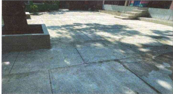
Foto 2: Reparación de banqueta y gradas de concreto.
